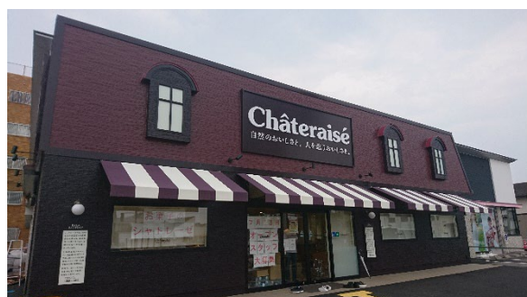
改装中の米子皆生通り店
